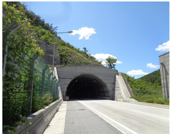
4공구 평호터널(상주방향) 종점부
