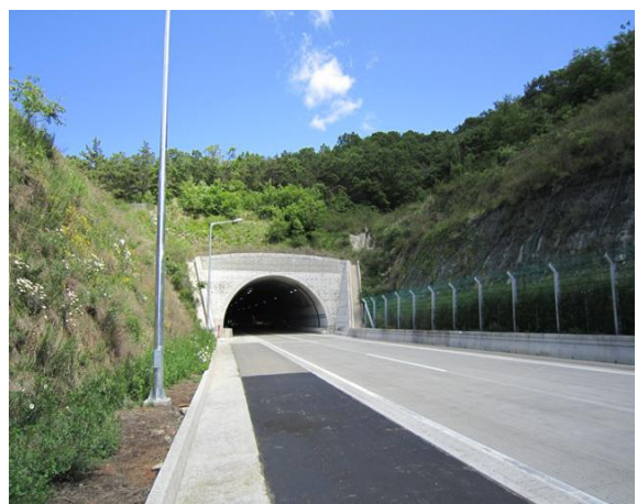
4공구 평호터널(영천방향) 종점부
