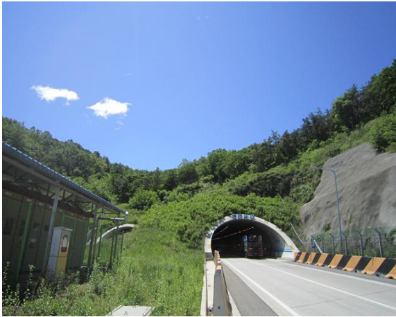
4공구 산법터널(영천방향) 시점부
