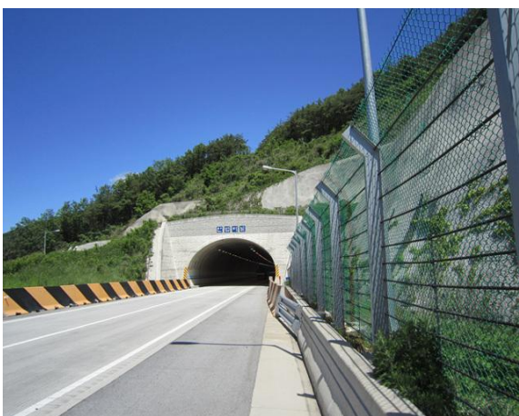
4공구 산법터널(상주방향) 시점부
