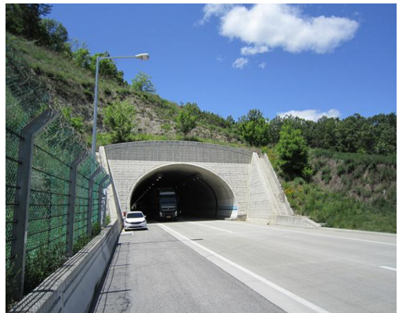
5공구 불로터널(영천방향) 종점부
