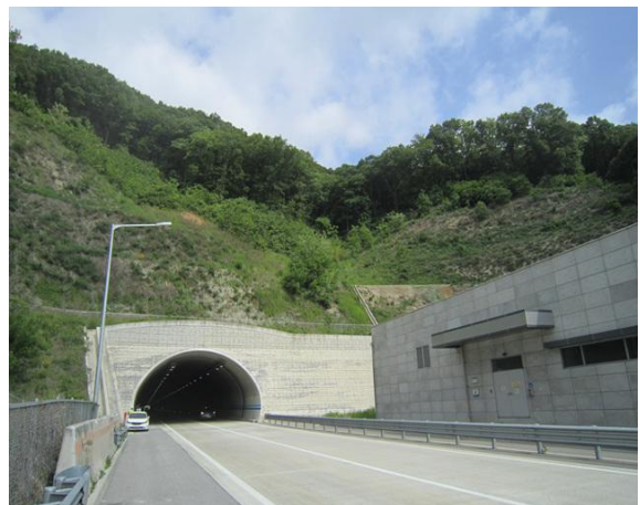
5공구 효령터널(영천방향) 종점부
