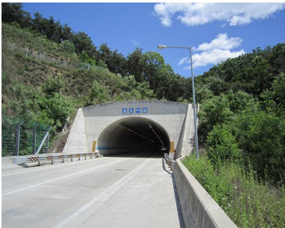
5공구 불로터널(영천방향) 시점부
