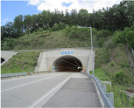
5공구 중구터널(영천방향) 시점부
