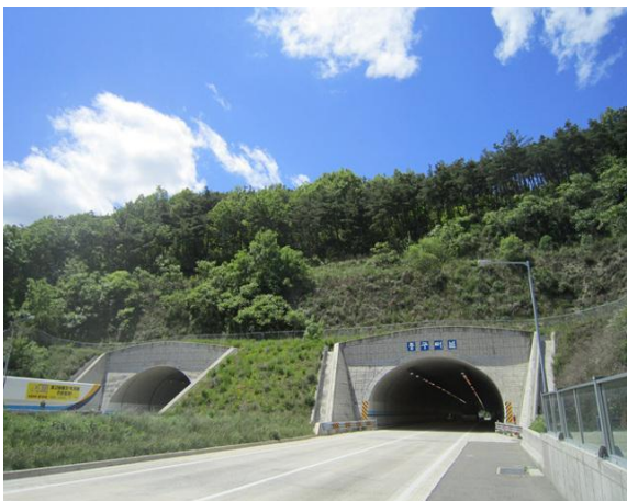
5공구 중구터널(상주방향) 시점부
