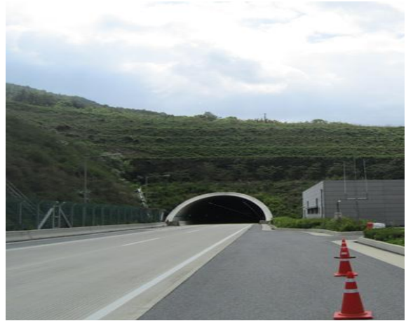
3공구 군위터널(상주방향) 종점부
