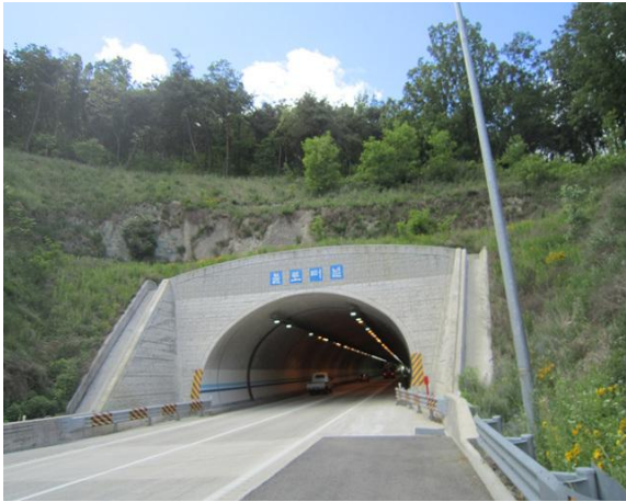
5공구 불로터널(상주방향) 시점부
