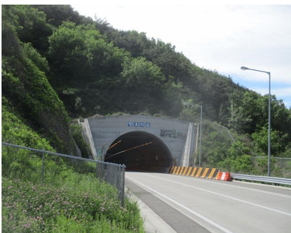
4공구 평호터널(영천방향) 시점부
