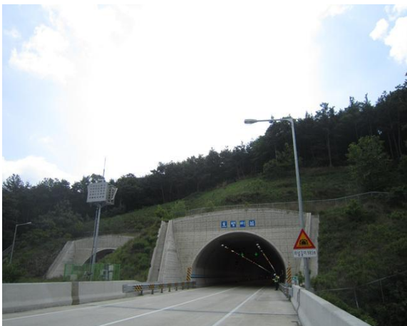
5공구 효령터널(영천방향) 시점부
