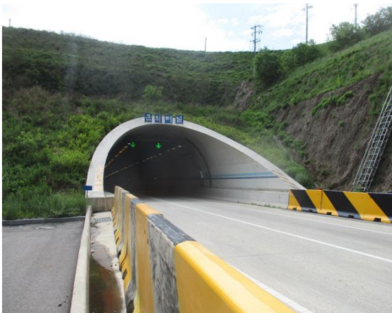
3공구 군위터널(영천방향) 시점부
