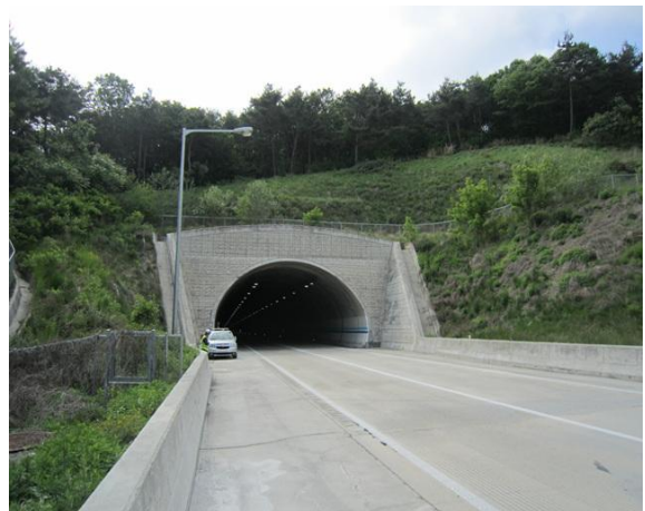
5공구 효령터널(상주방향) 종점부
