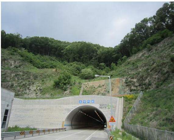
5공구 효령터널(상주방향) 시점부
