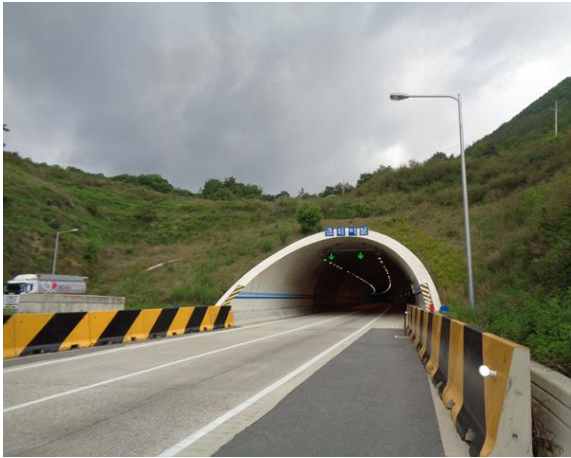
3공구 군위터널(상주방향) 시점부
