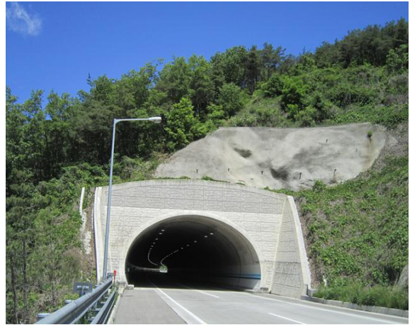
4공구 산법터널(영천방향) 종점부
