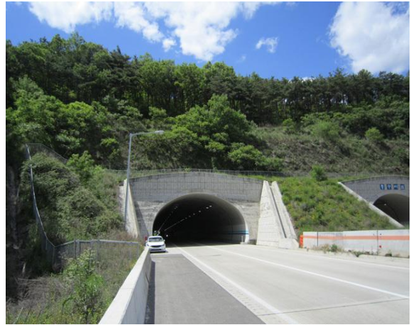
5공구 중구터널(영천방향) 종점부
