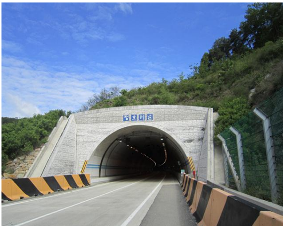
4공구 평호터널(상주방향) 시점부
