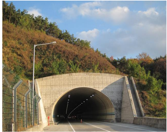
5공구 불로터널(상주방향) 종점부
