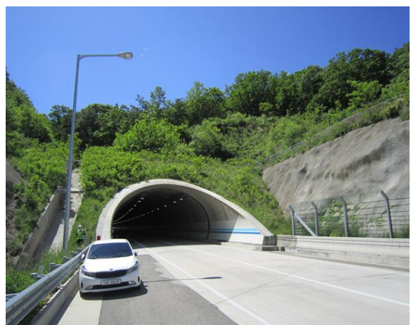
4공구 산법터널(상주방향) 종점부
