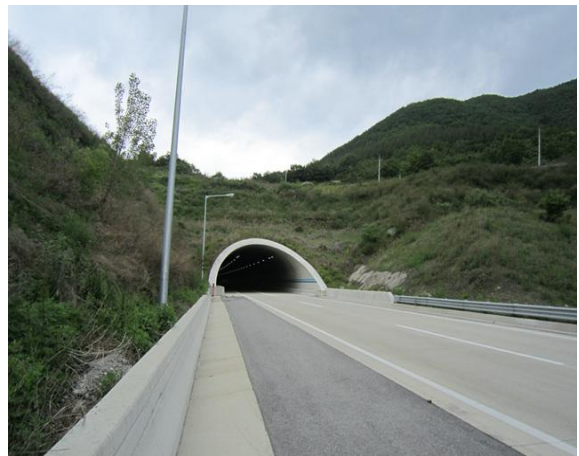
3공구 군위터널(영천방향) 종점부
